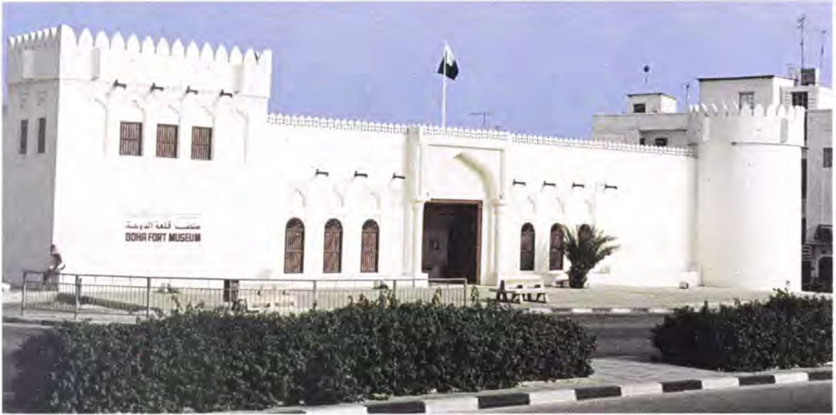
منظر عام للجهة الغربية لقلعة (الكوت) بعد الترميم
